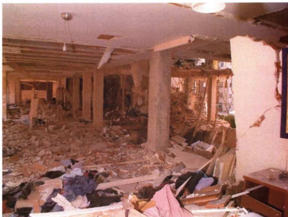
VISTAS DE LOS EFECTOS DE LA EXPLOSIÓN EN EL INTERIOR DEL EDIFICIO
