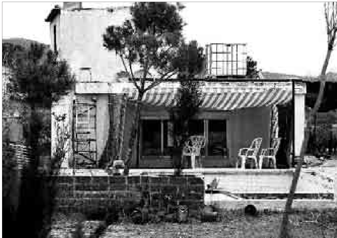
Fachada de la infravivienda situada entre los términos municipales de Chinchón y Morata de Tajuña. / KIKE PARA
